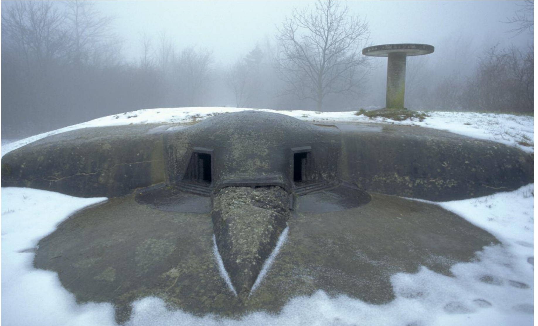
Casemate du Fort de Souville à Verdun
