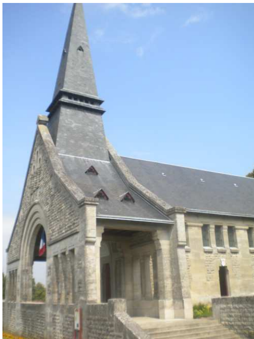
Vue extérieure de la chapelle du Souvenir Français – Bouchavesnes-Bergen © CD 80 – F. Dournel, 2012
